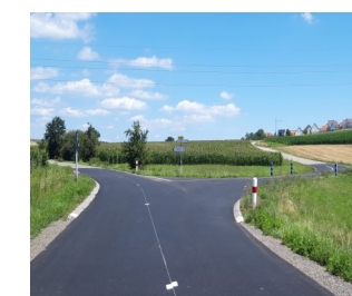
Aperçu des travaux RD326/RD726 et RD726/RD750
