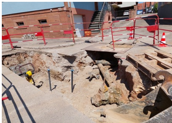
Croisement RD750/Rue du Château d'Eau / Rue de la Liberté
